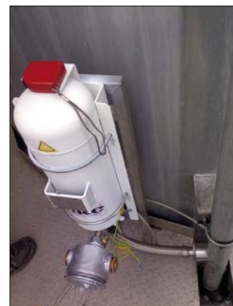
Rys. 4. Butla typu SRD do odsprężania wybuchów podczas serwisu
