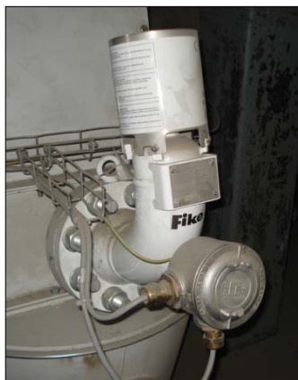
Butla HRD5L na stopie przenośnika kubelkowego jako izolacja wybuchu
