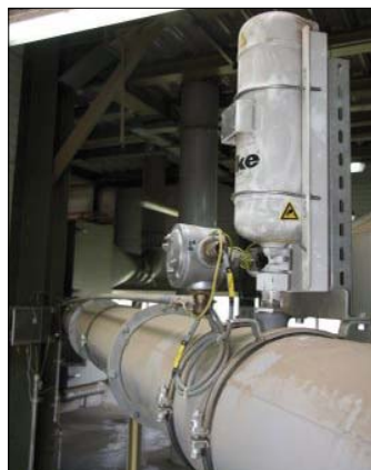
Butla odsprężająca wybuch mogący rozchodzić się od filtra w stronę instalacji (typ SRD)
